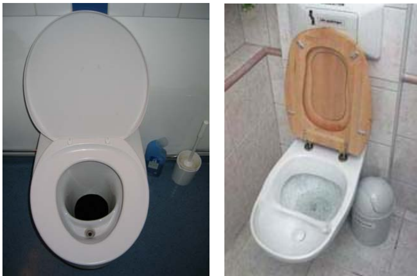
Figur 6. De urinsorterande toaletter som har installerats på Kullön: Gustavsbergs modell Nordic 393-U samt Dubblettens vägghängda modell.
